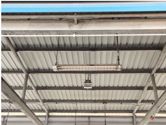
ระบบไฟฟ้าที่ใช้ภายในสถานีท่าอากาศยานหลักเป็นชนิดป้องกันการระเบิด (Explosion Proof)
