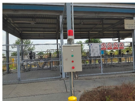
ติดตั้งระบบสัญญาณแจ้งเตือนเมื่อเกิดเหตุฉุกเฉิน
