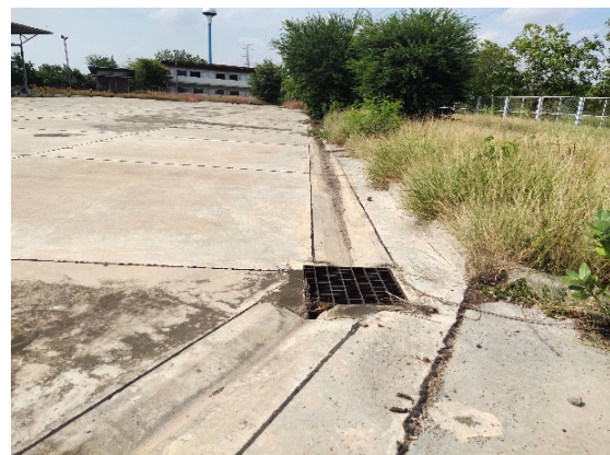
จัดทำรางระบายน้ำ และรางรวบรวมน้ำเสียไว้บริเวณจุดต่างๆ ภายในสถานีท่าเรือขนถ่ายสินค้าหลัก
