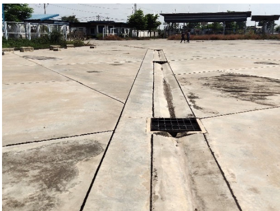
จัดทำรางระบายน้ำ และรางรวบรวมน้ำเสียไว้บริเวณจุดต่างๆ ภายในสถานีท่าเรือขนถ่ายสินค้าหลัก
